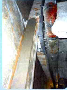
Remise de la poutre de rive en sous œuvre située au nord-est du bassin
