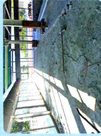
Démolition du carrelage et de la chape des plages de l'extension (non amiantés)
