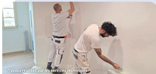
Travaux réalisés par les services techniques
